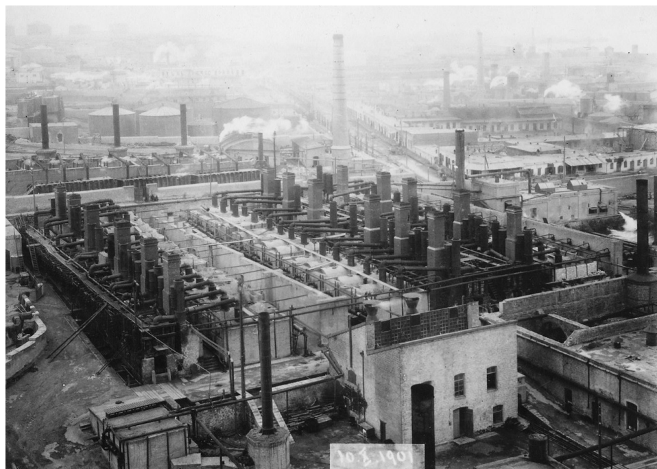
Кубовая батарея для непрерывной перегонки нефти по методу Д. Менделеева на одном из заводов «Братьев Нобель» в Баку.
